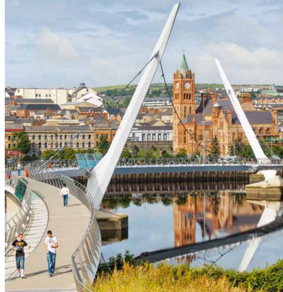
PEACE BRIDGE, DERRY-LONDONDERRY
